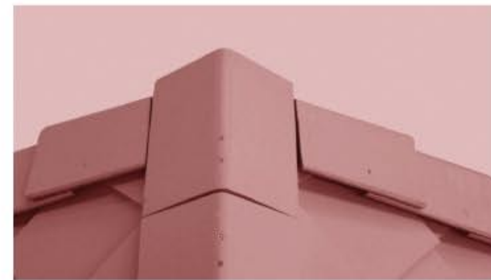
9. เริ่มทำมุงครอบสันหลังคาตราช่าง ซีแพคโมเนีย รุ่นโอเรียนทอล โดยเริ่มจากครอบปิดจั่วที่ทำการบากครอบปิดจั่วเข้ากับครอบบันลุ่มตั้งรูป จากนั้นยึดครอบด้วยตะปูเกลียวยึดกระเบื้อง 2.5 นิ้ว-ปลายสว่านให้แน่นพอสมควร
