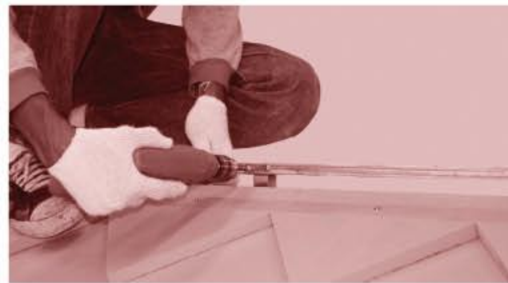
4. ยึดเหล็กยึดครอบติดกับขาเหล็กยึดครอบ ด้วยตะปูเกลียวยึดแปจำนวน 4 ตัว โดยเหล็กยึดครอบต้องอยู่ในระดับเดียวกัน และอยู่ในแนวกึ่งกลางสันหลังคา
