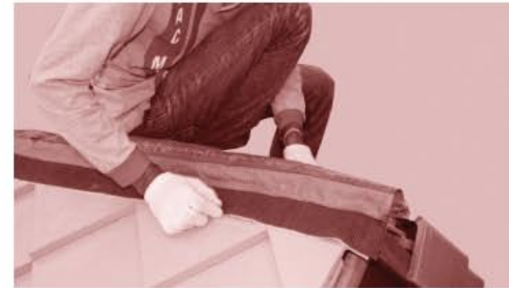
7. ก่อนติดตั้งแผ่นรองใต้ครอบตามแนวสันหลังคา ต้องมั่นใจว่าบริเวณที่ทำการติดตั้งต้องสะอาดปราศจากฝุ่นคราบน้ำมันและความชื้นแล้วจึงลอกแผ่นพลาสติกที่ปิดทับกาออก ทำการรัดแผ่นรองใต้ครอบให้แนบกับกระเบื้องสันหลังคาและคลุมแผ่นปิดรอยต่อ
