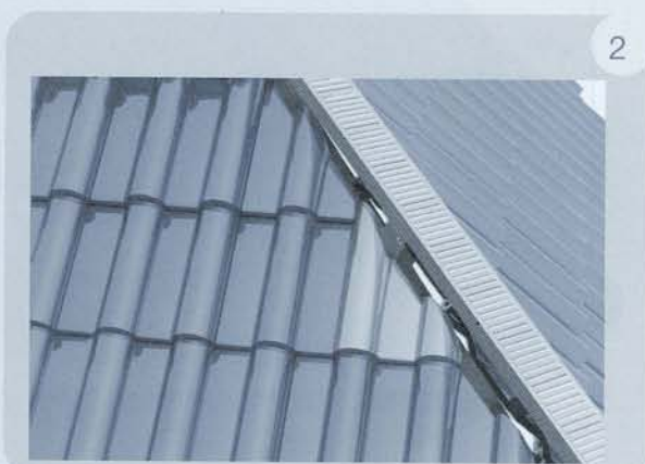
ภาพแสดงการใใส่เศษกระเบื้องใให้ครบทุกชั้น เพื่อใทำให้ใม่เกิดช่องว่างและใป้องกันใน้ำฝนซึมใเข้า และใให้เกิดความสวยงาม
