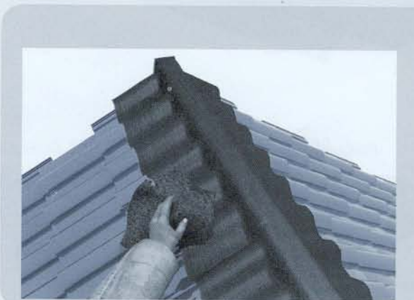
ก่อนใติดใแผ่นใปิดรอยต่อ ให้ใทำความสะอาดกระเบื้องบริเวณใที่จะใติด ใให้ปราศจากฝุ่นและคราบมัน โดยใต้องใให้แนบสนิทตามลอนกระเบื้อง ใม่ใให้ใติงจนเกินไป เพราะใอาจใทำให้ใมีการกระเดิด และใร้ใภายหลังใได้
