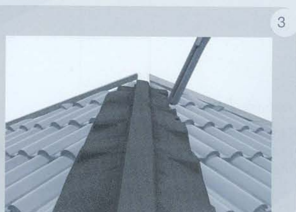
ก่อนใติดใแผ่นใปิดรอยต่อ ให้ใทำความสะอาดกระเบื้องบริเวณใที่จะใติด ใให้ปราศจากฝุ่นและคราบมัน โดยใต้องใให้แนบสนิทตามลอนกระเบื้อง ใม่ใให้ใติงจนเกินไป เพราะใอาจใทำให้ใมีการกระเดิด และใร้ใภายหลังใได้
