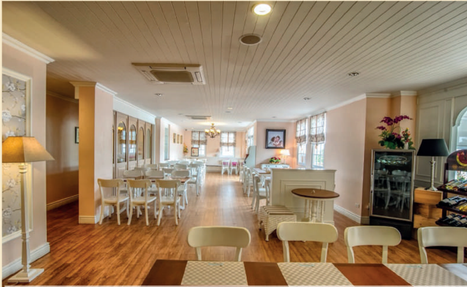
ตกแต่งฝ้าภายในด้วย ไม้ระแนง เอสซีจี ซีซีเมนต์ ทากับด้วยสีน้ำอะคริลิกสีขาว ช่วยให้เพดานดูสวย สะอาดตา และลายเส้นที่ช่วยเสริมสร้างให้เพดานดูมีมิติมากขึ้น สถานที่ : ร้านวีไลวรรณ หัวหิน จ.ประจวบคีรีขันธ์
