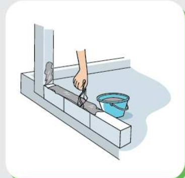
4. ป้ายปูนก่อนหลังอิฐชั้นแรกและข้างเสา
