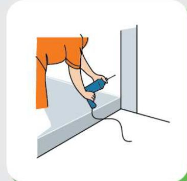
2. เจาะรูด้วยสว่านที่ข้างเสา
