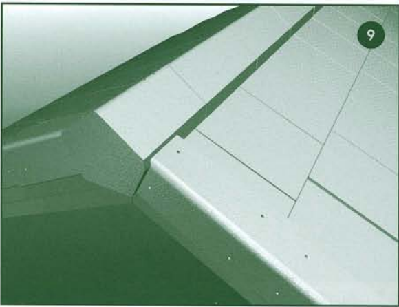
จัดเรียงครอบสันหลังคาตลอดแนวเพื่อเฉลี่ยระยะครอบ ซึ่งสายเอ็นที่มูมยอดของครอบปิดจั่วทั้งสองด้านเพื่อบังคับแนว แล้วยึดครอบสันหลังคา กับเหล็กรับครอบด้วยตะปูเกลียว 2.5 นิ้ว-ปลายสว่าน ทุกแผ่นๆ ละ 2 ตัว
