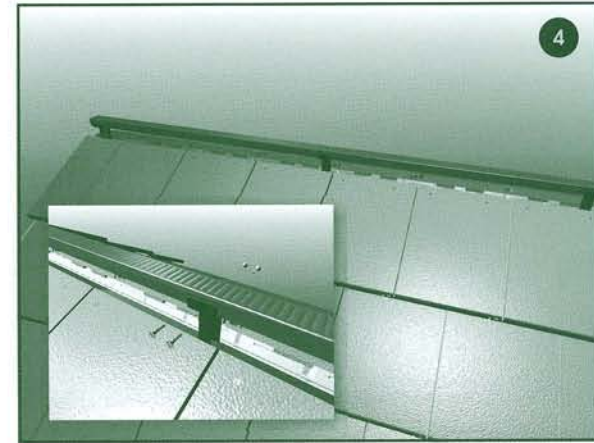
ยึดเหล็กรับครอบติดกับชายยึดเหล็ก ด้วยตะปูเกลียวยึดแปจำนวน 4 ตัว โดยเหล็กรับครอบต้องอยู่ในระดับเดียวกัน และอยู่ในแนวกึ่งกลางสันหลังคา
