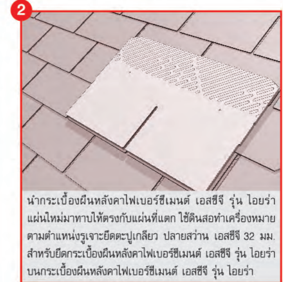
กรณีมีกระเบื้องพื้นหลังคาไฟเบอร์ซีเมนต์ เอสซีจี รุ่น โอयर่า แตกร้าวบนหลังคา
