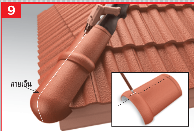
9 ติดตั้งครอบโค้งทางมนเป็นแผ่นแรก โดยยึดกับเหล็กรับครอบด้วย ตะปูเกลียว 2.5 นิ้ว ปลายสว่านให้แน่นพอควรจากนั้นเรียงครอบสันโค้ง ตลอดแนวตะเข้พร้อมซึ่งสายเอ็นบังคับแนวครอบสันโค้งที่ทำเครื่อง หมายกึ่งกลางหัวครอบให้ได้แนวตรงยึดครอบสันโค้งด้วยตะปูเกลียว 2.5 นิ้ว ปลายสว่านทุกแผ่นแน่นพอสมควร
