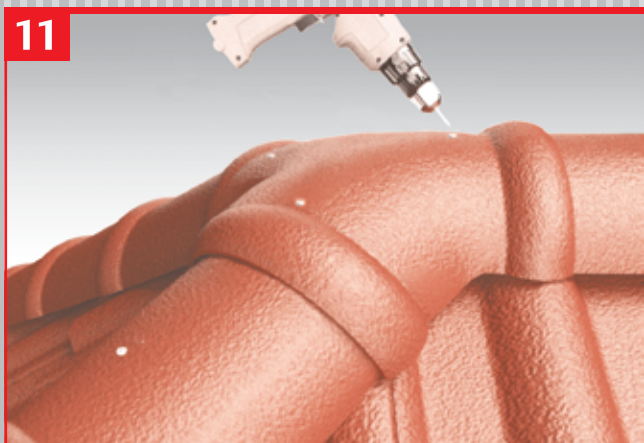
11 บริเวณจุดต่อระหว่างครอบตะเข้สันและครอบสันหลังคาให้ใช้ครอบโค้ง 3 ทาง ปิดทับ พร้อมยึดตะปูเกลียว 2.5 นิ้ว ปลายสว่านทั้ง 3 ด้าน ให้ แน่นพอควรแนวครอบสันโค้งบริเวณตะเข้สันทั้งสองด้านต้องได้แนว ตรงและระดับหลังครอบสันโค้งต้องเท่ากันทุกแผ่น
