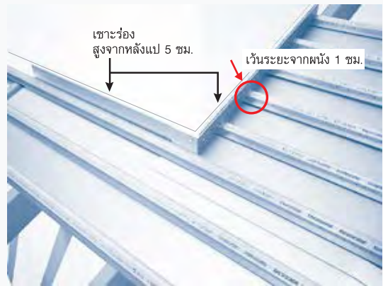
3. ติดตั้งแป Excella กับบนแผ่นสังกะสีโดยยึดแปติดเข้ากับจันทันด้วยตะปูเกลียวยึดแปสำหรับด้านที่ชิดผนังให้เว้นระยะหัวแปห่างจากผนังประมาณ 1 ซม. ทำการเซาะร่องผนังด้วยใบตัดคอนกรีต สูงจากผนังประมาณ 5 ซม. ลึกประมาณ 1 ซม. ยาวตลอดแนว ที่จะติดตั้งแผ่นรองหลังคา
