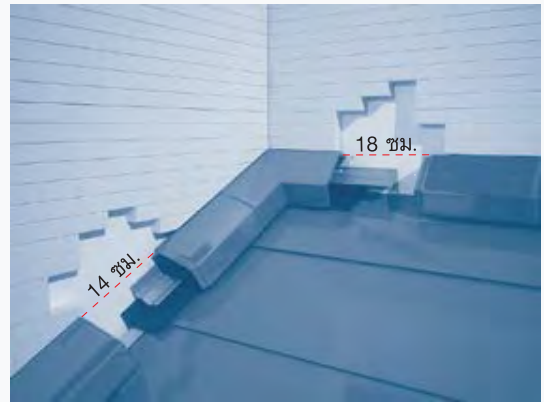
1. เว้นระยะไว้สำหรับติดตั้งครอบข้างและครอบหัวกระเบื้อง
