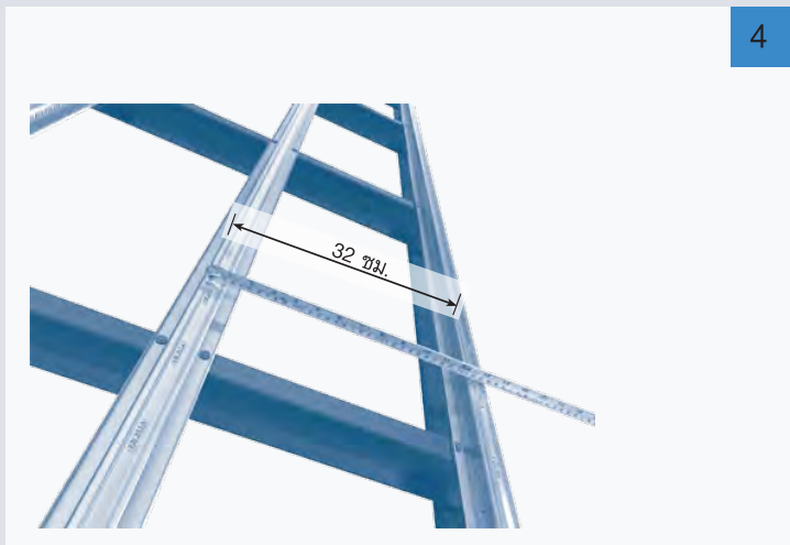
4. วัดระยะจากริมนอกไม้บัวเชิงชาย จนถึงหลังแปเท่ากับ 32 ซม..
