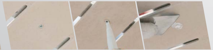
2. ตัดตั้งฝ้า สมาร์ทบอร์ด 4-6 มม. ได้งานเรียบร้อย สวยงาม
